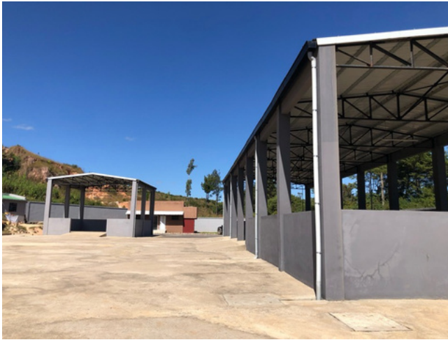
Centre de tri construit mais non opérationnel en raison des bacs à tri bloqués à Tamatave, Antsirabe.
